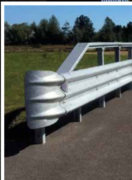
Strada Statale 57 - Polonia
