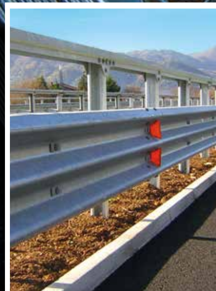
Autostrada A14 - Italia
